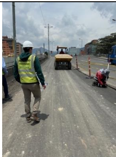
Foto 12: fecha: 09/04/2024 Hora: 10:55 am Extendido asfalto sobre el puente de la calle 100 con autopista
