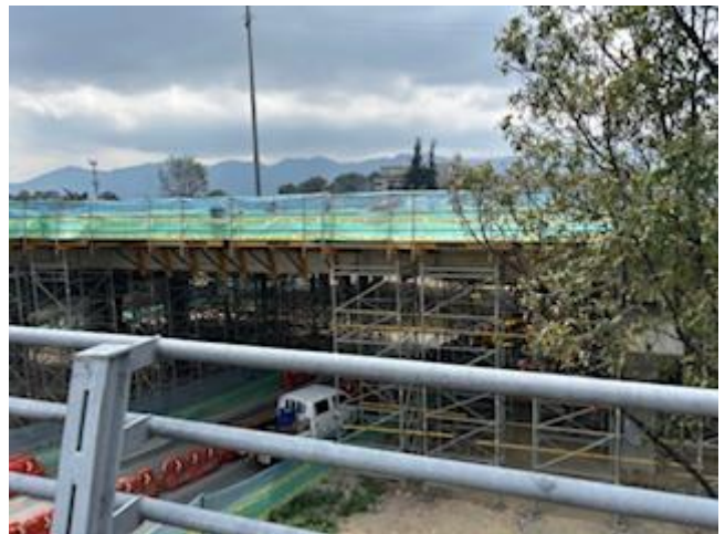
Foto 2: fecha: 09/04/2024 Hora: 7:41 am Formaleta Accesos puente conectante troncal Transmilenio Avenida 68
