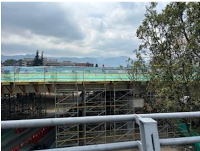
Foto 1: fecha: 09/04/2024 Hora: 7:40 am Formaleta puente conectante troncal Transmilenio Avenida 68
