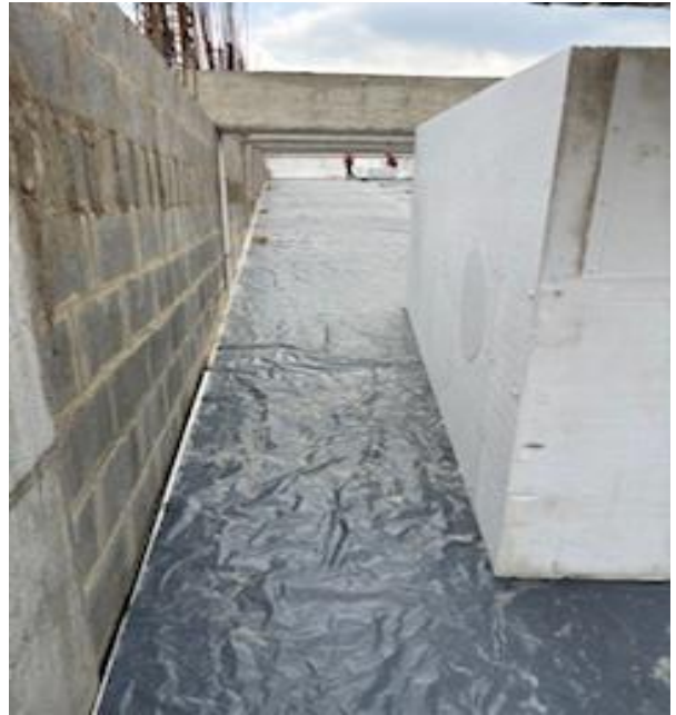
Foto 2: fecha: 09/04/2024 Hora: 7:43 am Geobloques puente conectante troncal Transmilenio Avenida 68
