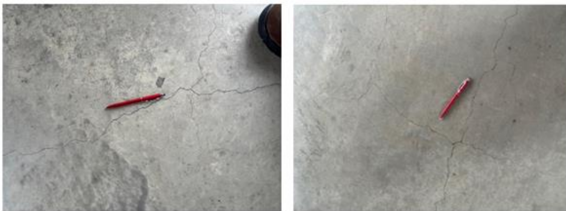
Imagen 9 Fisuras en Losas de piso en la Estación Biblioteca El Tintal. Avenida Ciudad de Cali.
