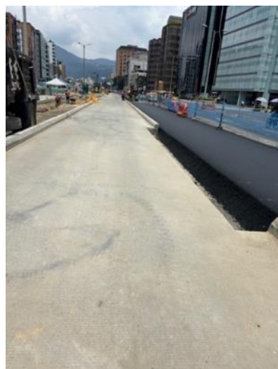
Foto 14: fecha: 09/04/2024 Hora: 11:05 am Extendido de asfalto acceso carril mixto puente calle 100 con autopista
